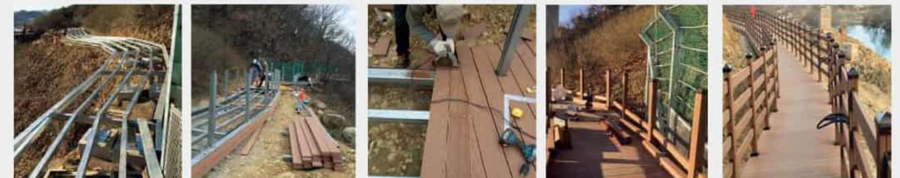
① 하지 작업 ② 데크 설치 전 난간 기둥용 속주 설치 ③ 데크설치 및 마감 ④ 난간 설치 ⑤ 완성
